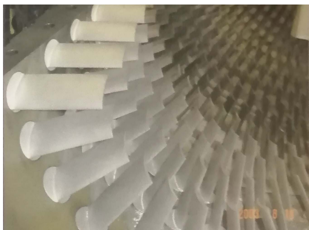
شکل ۲۵- پره های نصب شده
