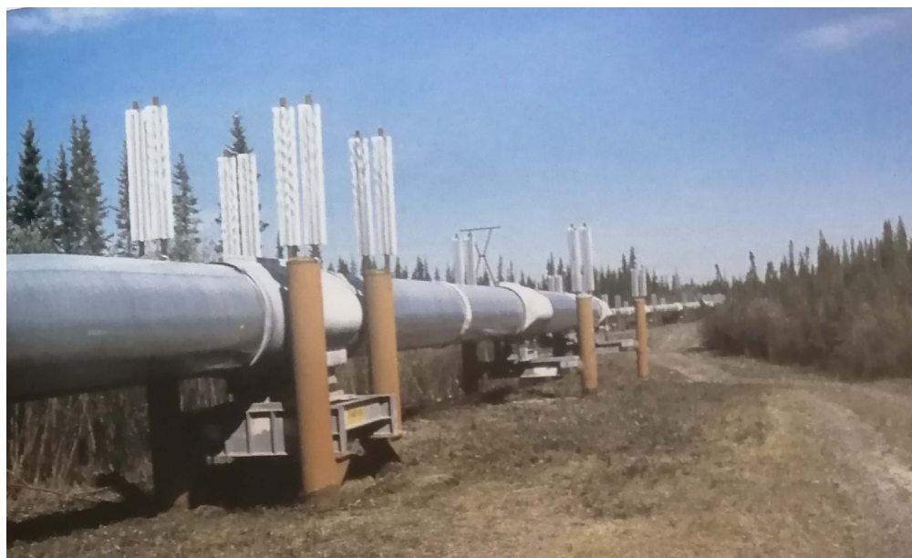
شکل ۹- استفاده از توربین در پمپاژ خطوط لوله
