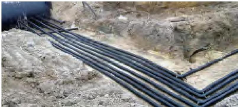
**عکس ۱. لوله‌کشی HDPE** افقی که با فاصله حداقل ۴ فوت (۱,۲ متر) زیرزمین نصب شده در یک چیدمان برگشت معکوس، لوله‌کشی رفت و برگشت هر گودال را به گند HDPE متصل می‌کند؛ این چیدمان افت فشار سیستم و انرژی لوله‌کشی مربوطه را به حداقل می‌رساند.
