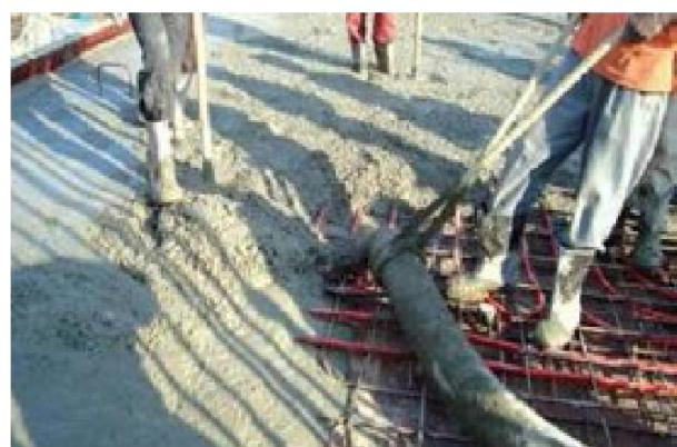
شکل ۳: نمایی از نحوه بتن ریزی بر روی لوله ها در سیستم سرمایش تشعشعی
