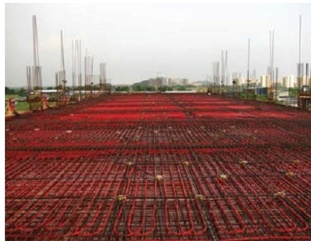
شکل ۴: نحوه انجام سیستم سرمایش تشعشعی با لوله های پکس دارای لایه محافظ اکسیژن
